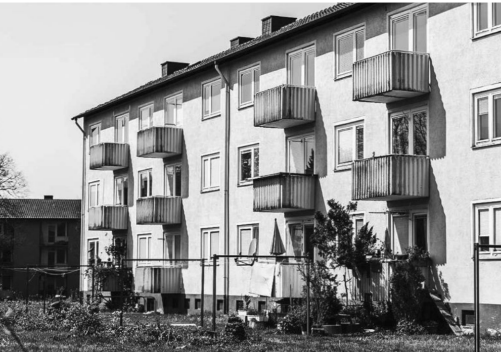
Die Substanz der Altbauten war nicht mehr sanierungsfähig.
