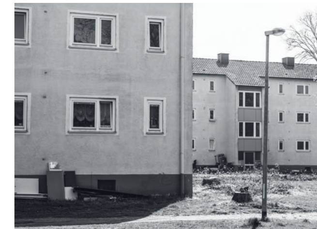
Die ECA-Siedlung in Freiburg bestand aus neun Gebäuden mit überwiegend Kleinwohnungen.
